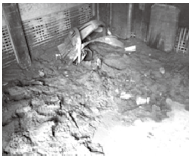
愛媛県内の会員施設の様子 約2メートルの浸水があり、溶け崩れた土壁が一面に堆積
